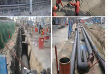
部分成果 1、现场拆除设备及管线部分，现场发现
